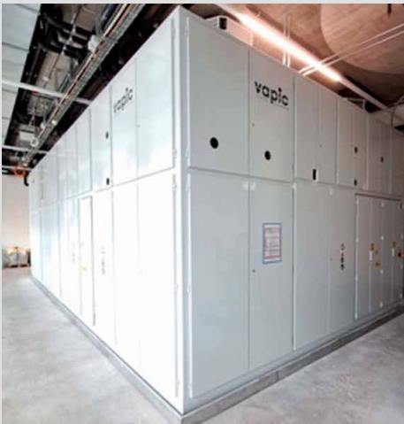
Die Kammeranlage von vapic ersetzt eine Durchlauf-Entfettungsanlage.
