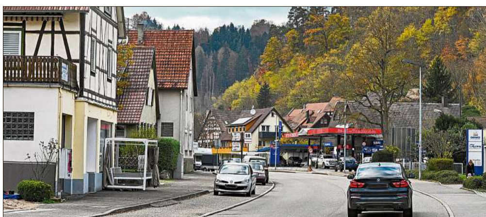
Auf der B 463 in Wildberg starten am Montag, 16. November, die Tiefbauarbeiten für die Erweiterung des Gas-Netztes. Foto: Fritsch
